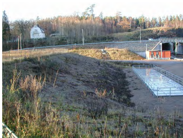
Jordvallen och spårområdet med magasinet för släckvatten i norra delen av planområdet
