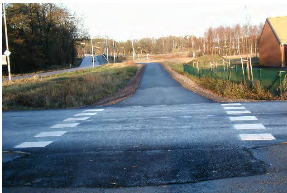
Gång- och cykelbana utmed Vårviksvägen, väster om planområdet.
